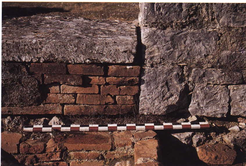
FOTO 7 – Pormenor do fechamento da janela de C21 (visto do tanque C24).
