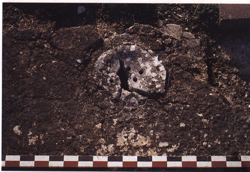
FOTO 8 – Esgoto de superfície na zona perimetral de C25 (perdido todo o tessellatum, resta o opus signinum de suporte).
