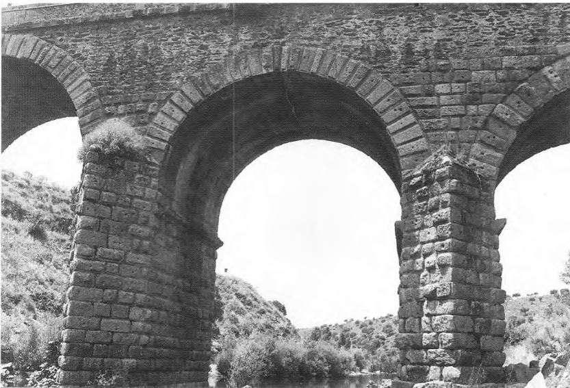
b) Tajamares (segundo arco – reconstruido – desde la Orilla Portuguesa). A la derecha original, al a izquierda reconstruido.
