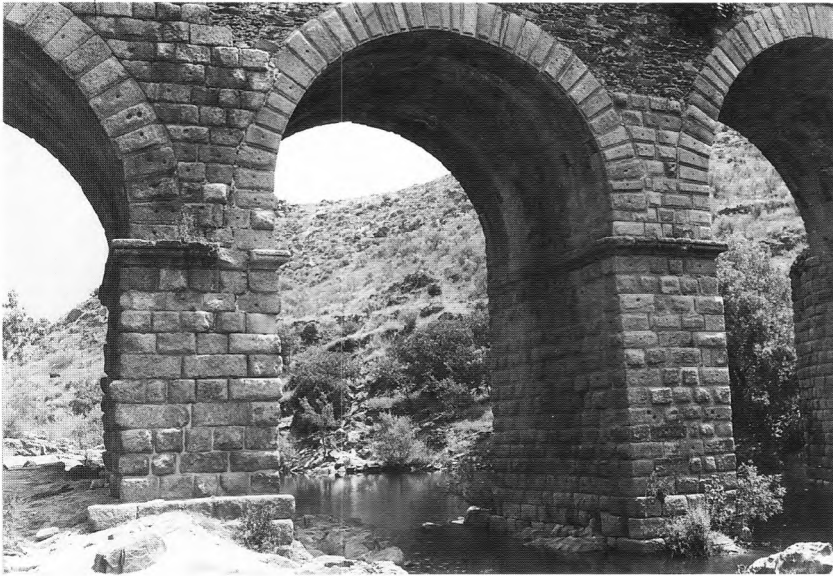
a) Arco reconstruido segundo desde la Orilla Portuguesa e inicio del arco central
