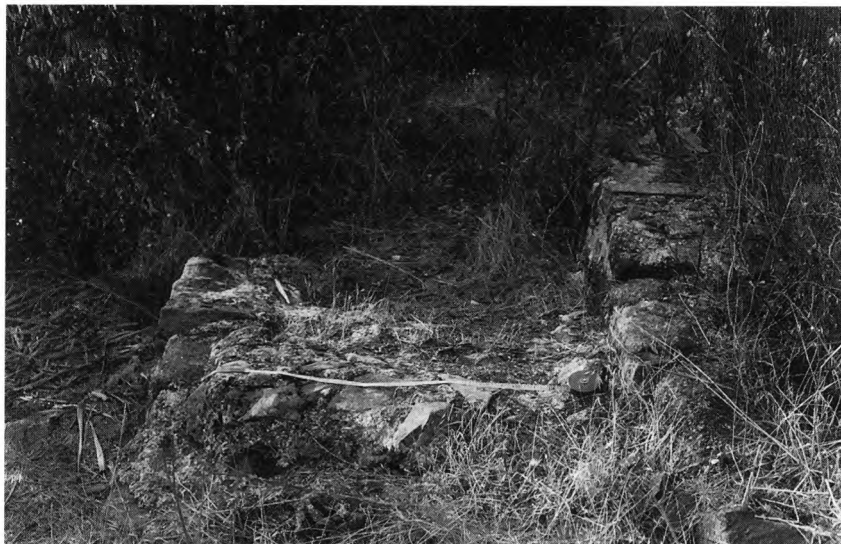
FOTO 21 – Barragem de Nossa Senhora de Mércules (Castelo Branco)
