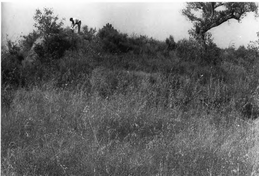
FOTO 3 – Barragem da Orca (Fundão). Vista geral do aterro na margem esquerda, de jusante, notando-se a escarpa da brecha
