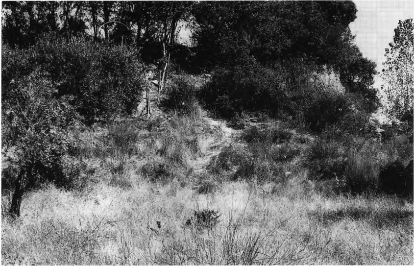
FOTO 14 – Barragem da Egitânia (Idanha-a-Nova). Vista de jusante, notando-se à direita o início do talude da brecha
