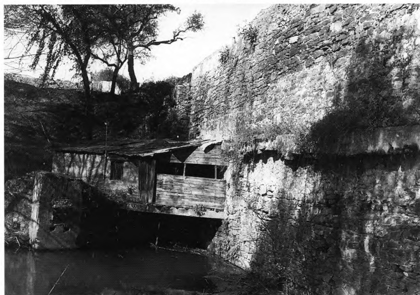
FOTO 30 – Barragem de Alferrarede (Abrantes). Vista do paramento de jusante a partir da margem esquerda, notando-se, restos de moinho e caleira adossada ao muro, a meia altura
