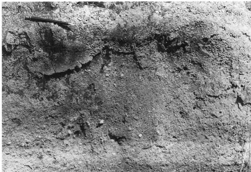
Foto 5 – Barragem da Orca (Fundão). Vista do pormenor da estrutura do aterro na brecha, evidenciando a execução do aterro por camadas
