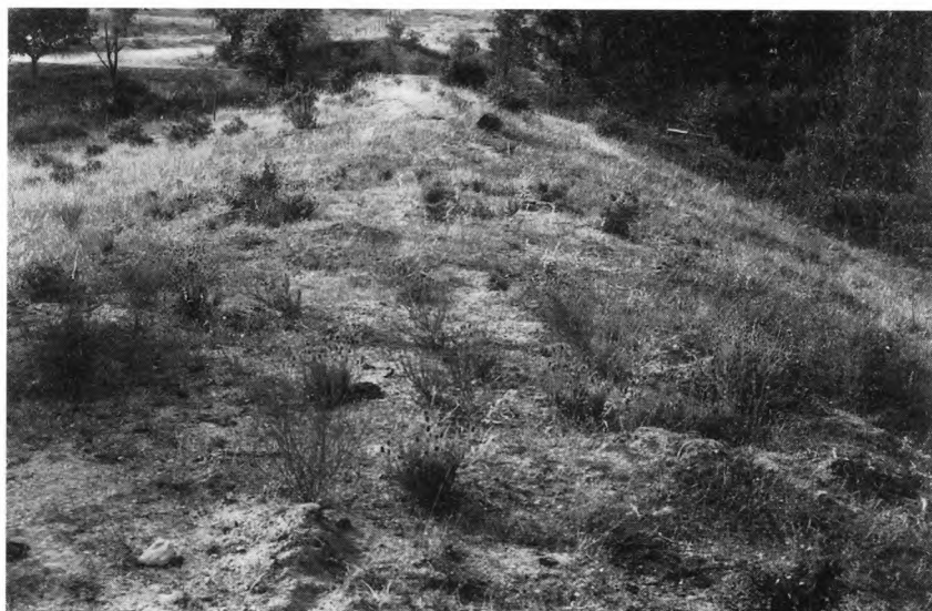
FOTO 22 – Barragem de Monforte (Castelo Branco). Vista geral do aterro obtida para a margem direita
