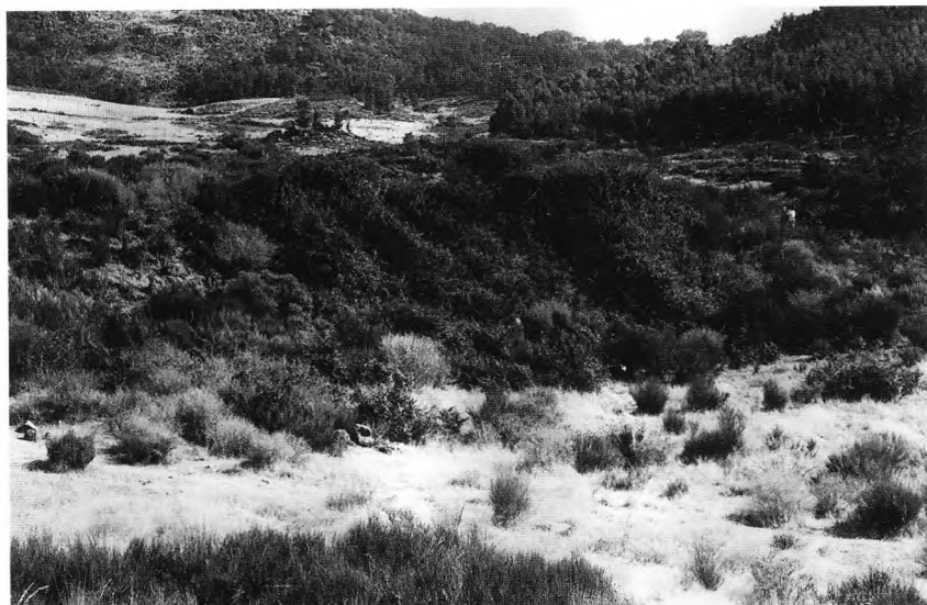
Foto 9 – Barragem do Rochoso (Idanha-a-Nova). Vista geral do aterro na margem direita, observando-se na zona central o talude de jusante, coberto de mato, e o de montante, com pente mais suave, em pousio
