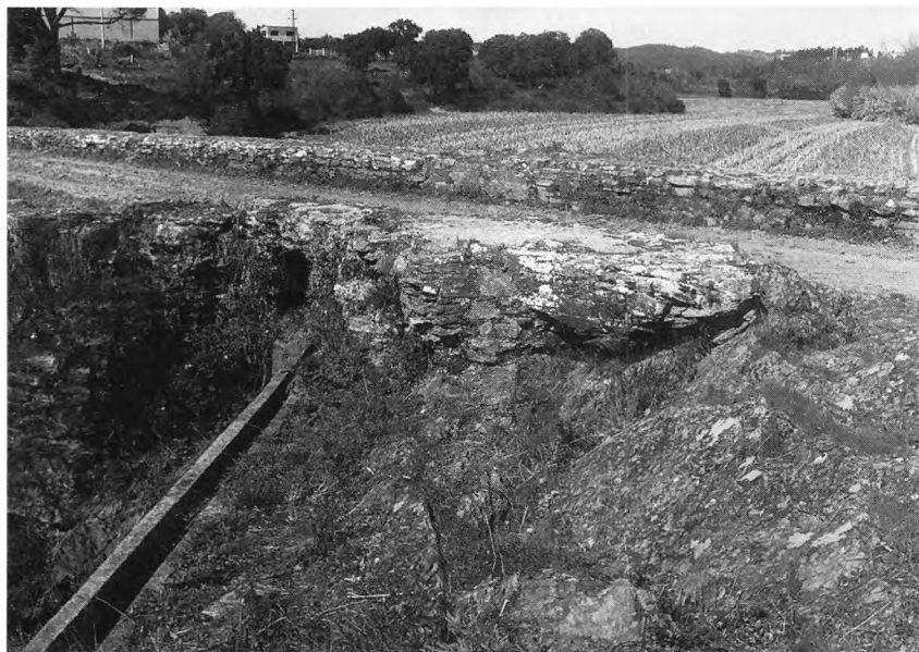
Foto 32 – Barragem de Alferrarede (Abrantes). Vista de jusante, notando-se, em primeiro plano, uma caleira de construção recente e, em último plano, a albufeira assoreada
