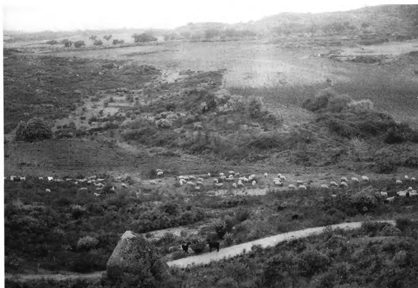
Foto 10 – Barragem do Rochoso (Idanha-a-Nova). Margem direita vista de jusante
