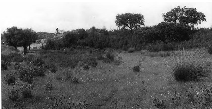
FOTO 23 – Barragem da Lameira (Vila Velha de Ródão). Vista do aterro, obtida de jusante na margem esquerda
