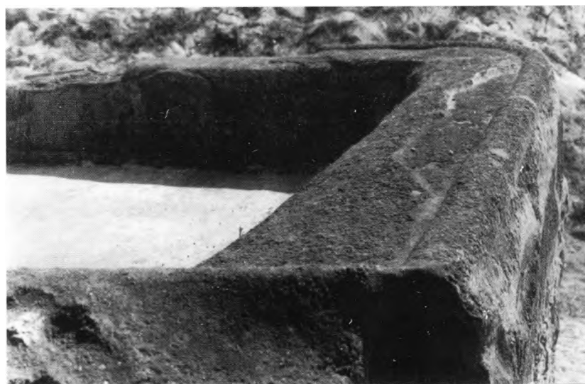
FOTO 4 - Instalação hidráulica de Tróia. Pormenor do muro do tanque
