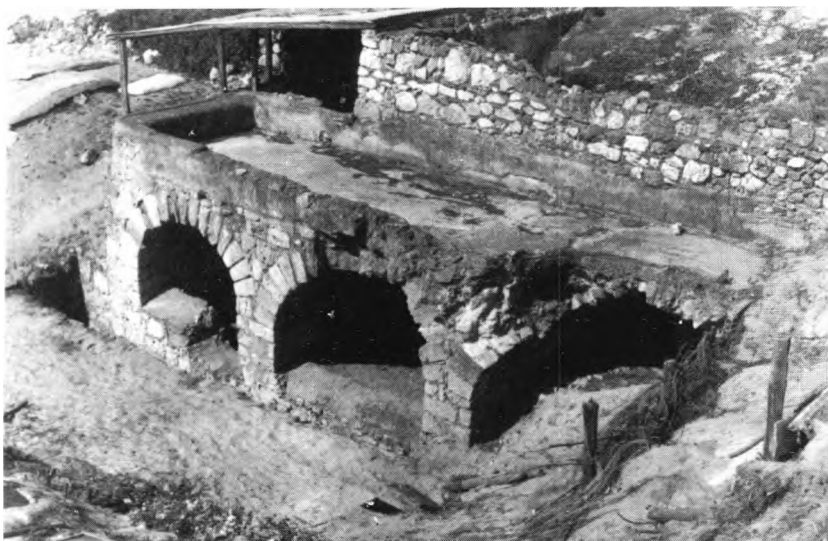
FOTO 2 - Instalação hidráulica de Tróia. Vista geral, notando-se o poço e a abóbada norte parcialmente destruída
