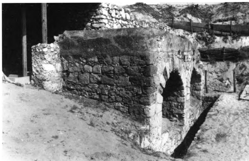
FOTO 3 - Instalação hidráulica de Tróia. Vista geral, notando-se o poço e o revestimento exterior do tanque
