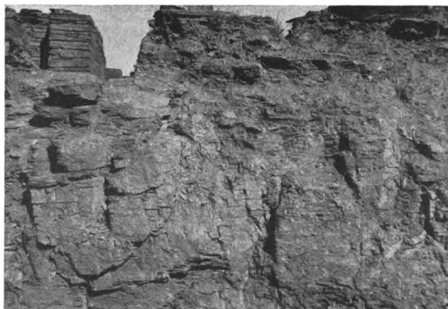
FIG. 4 — Outro aspecto da rocha xistosa que foi cortada para abertura do fosso que defende o fortim pelo lado Este. É de notar a alteração que apresenta. Na parte superior ficam as muralhas do Castelo.
