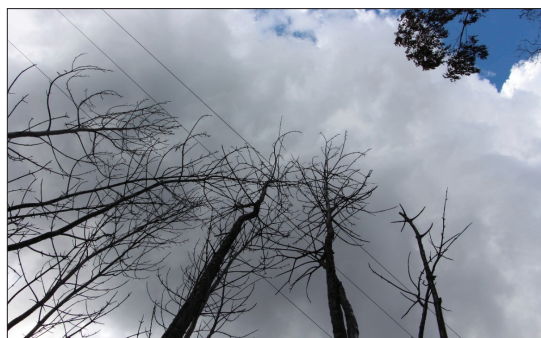
Fot. 9 - Aspetto geral da linha elétrica de média tensão e dos pinheiros situados por baixo dela (Fonte: Arquivo da Diretoria do Centro da Polícia Judiciária).
