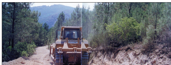
Fot. 10 - Aspeto da abertura de uma estrada de terra batida (Fonte: CNEFF, 1999).
