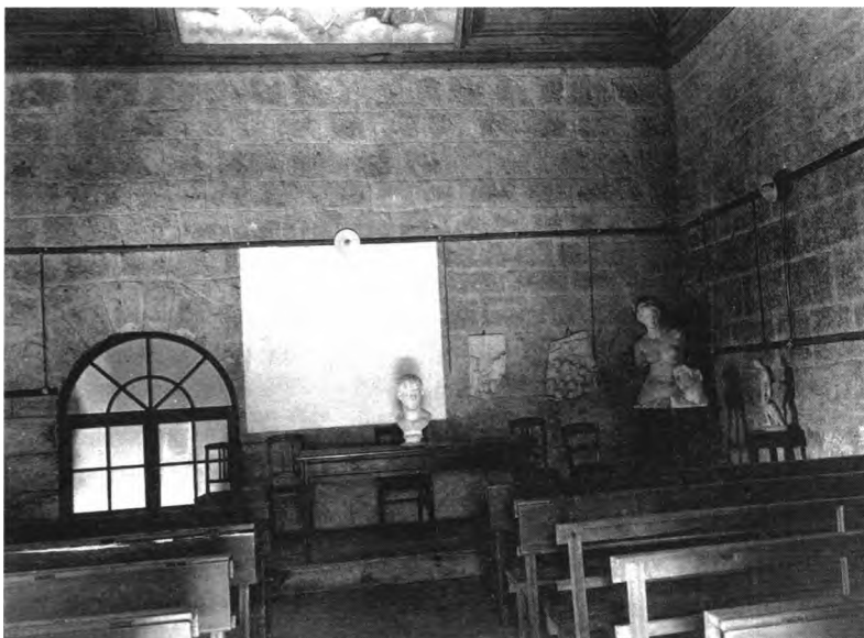
Foto 2 - Sala do 1º Andar da Torre de Almedina, quando era utilizada pela ELAD. Realça-se no canto inferior direito, por detrás da estátua, o arco entaipado, da porta que dá acesso à “Casa das Bonecas” e no topo da fotografia é possível visualizar o tecto em forma de masseira com painéis pintados. Foto cedida por cortesia da DREMN.
