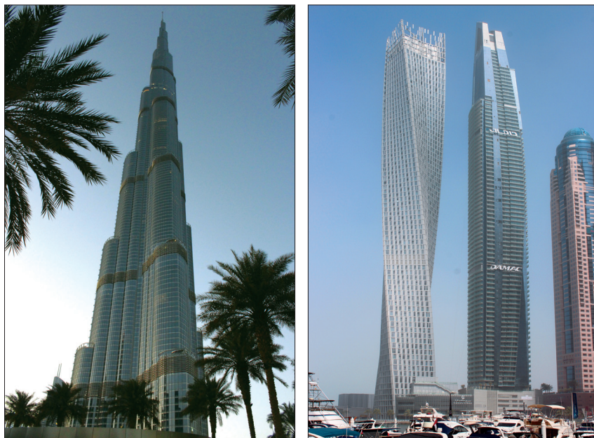
Fot. 1 - Edificações localizados no Dubai: à esquerda o 'Burj Khalifa' com 160 andares e 828 m de altura; à direita a 'Cayan Tower' com uma forma helicoidal e 306 m de altura (Fotografias: cortesia de Ana Raquel Carmo, março de 2018)
