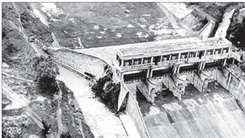
Fot. 12 - Albufeira de Banqiao e Shimantan ( http://www.pensamentoverde.com.br/meio-ambiente/conheca-alguns-dos-maiores-desastres-com-barragens-no-mundo/ ).
