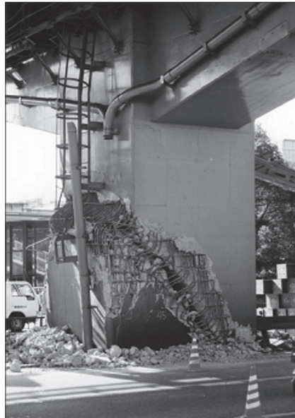
Fot. 13 - Cedência de um tabuleiro e falhas por esmagamento e/ou cisalhamento ocorridas na base e a meio de pilares de pontes em Kobe, Japão, na sequência do sismo de 1995 (Fonte: Bruneau, 1998).
