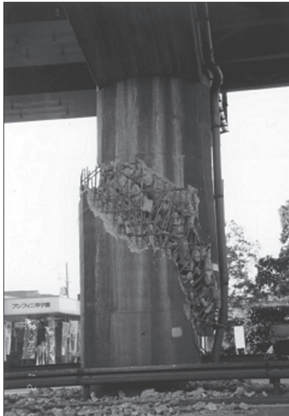
Fot. 13 - Cedência de um tabuleiro e falhas por esmagamento e/ou cisalhamento ocorridas na base e a meio de pilares de pontes em Kobe, Japão, na sequência do sismo de 1995 (Fonte: Bruneau, 1998).
