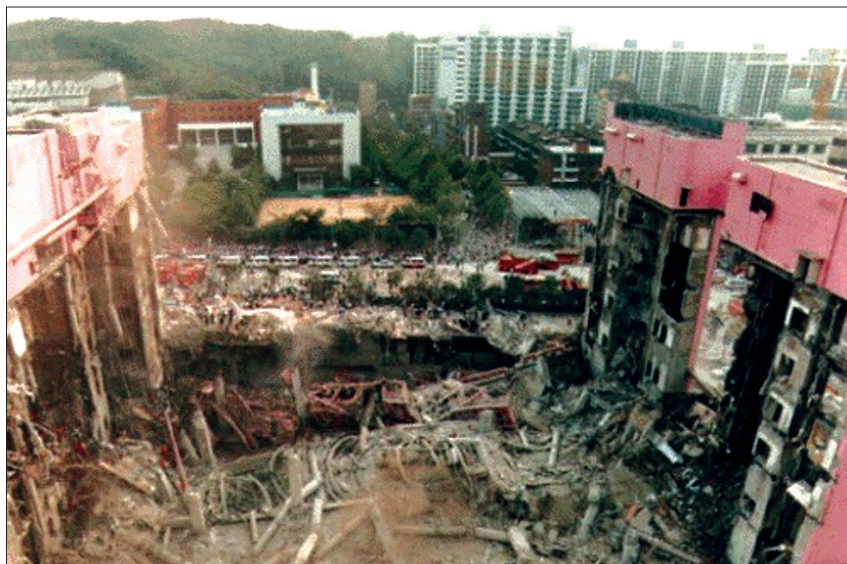
Fot. 17 - Armazéns do departamento Sampoong, Seul, Coreia do Sul.
