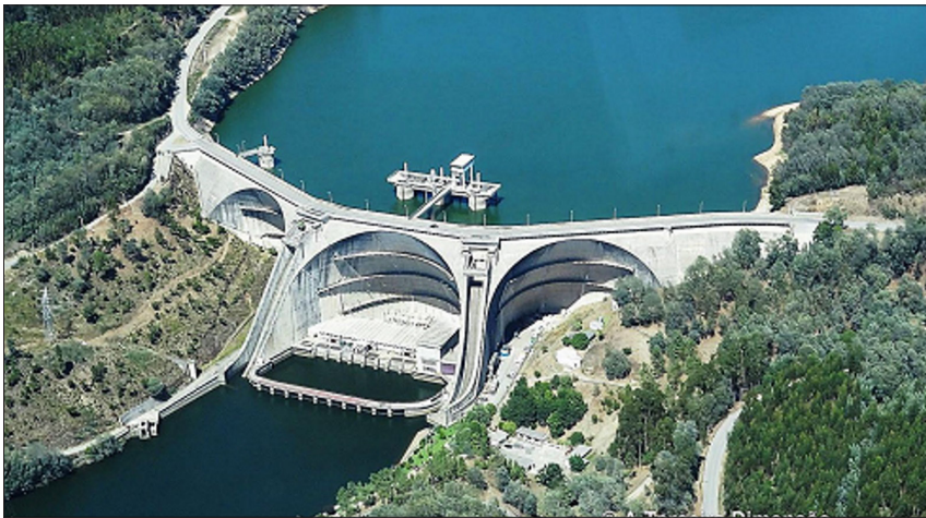
Fot. 7 - Barragem de abóbadas múltiplas (Aguieira, Portugal) (INRH, 2016).
