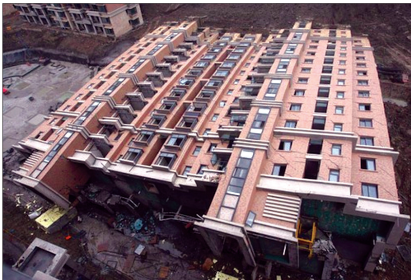
Fot. 18 - Colapso de um bloco do complexo ribeirinho Lotus Riverside, Xangai, China.
