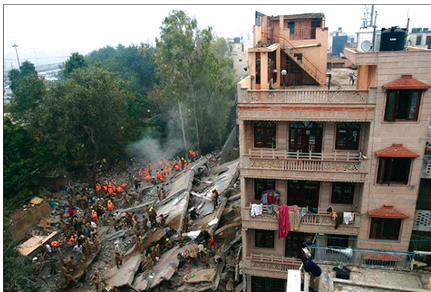
Fot. 19 - Colapso de um edifício em Nova Deli, Índia.
