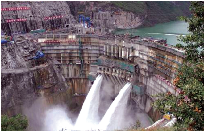
Fot. 3 - Barragem de arco mais alta do mundo na atualidade, com 305 m: Jinping-I, China ( http://en.powerchina.cn/2016-12/28/content_27870606.htm ).
