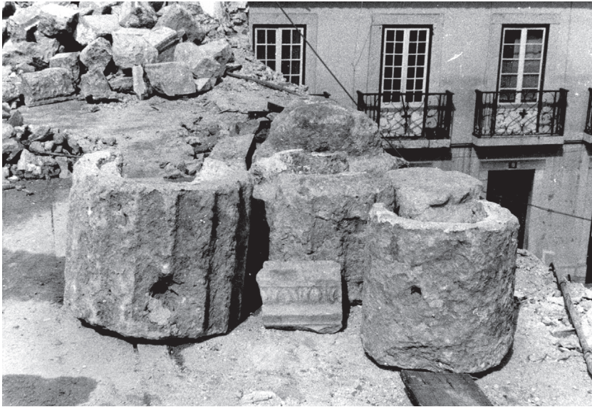
FIG. 1 – Aspetto das demolições realizadas entre 1965 e 1967 dos edifícios sobrepostos aos vestígios do teatro romano. (Museu de Lisboa).
