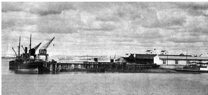
Fig. 1. Construído para escoar a produção da mina dos Monges, o desaparecido terminal mineiraleiro do Barreiro (Ponte dos Ingleses) serviu a outras cargas e descargas. Foi desativado para a realização do aterro em que assentou o terminal rodo-fluvio-ferroviário inaugurado em 1995. F. autor desconhecido, anos 1940. Cortesia do Arquivo Espaço Memória, CMB.
