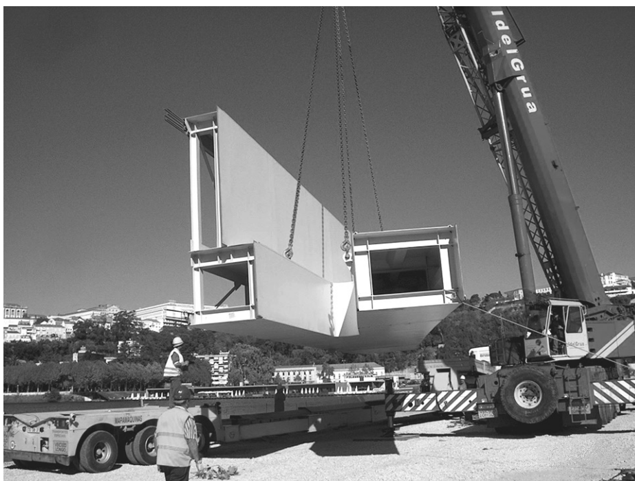
Figura 7.4. Descarga de uma das peças metálicas da ponte Pedro e Inês, em Coimbra. Movimentação da peça na posição deitada.
