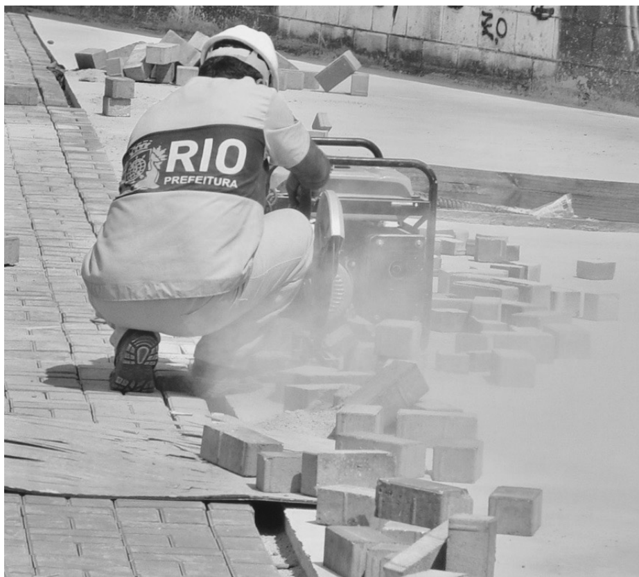
Figura 6.3. Na obra do estádio olímpico do Rio de Janeiro evitar-se-ia muito trabalho de corte de calçada em betão, bem como inalação de poeiras, se a largura das passadeiras não fosse “3,00m” mas sim “15 peças inteiras”. (Foto do Autor)
