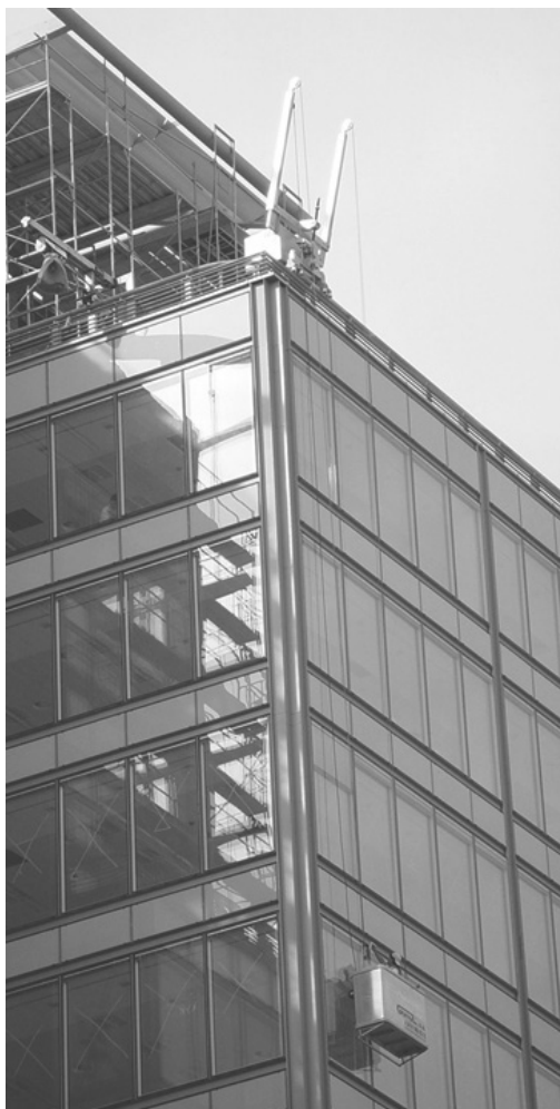
Figura 7.2. Bailéu previsto em projeto não só para a realização de operações na fase de construção em curso, mas também para a limpeza e manutenção dos envidraçados fixos do edifício. ( Foto do Autor )
