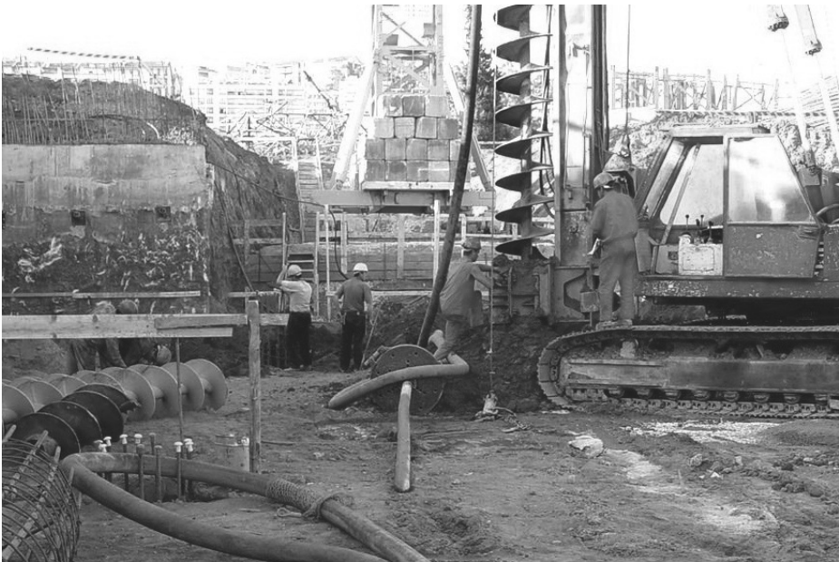
Figura 2.7. Execução de estacas por trado contínuo. A par do manobrador e pessoal de apoio na operação de posicionamento do trado, há outros trabalhos na proximidade envolvendo outros operários. (Foto do Autor)
