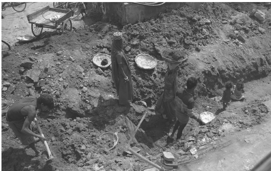
Figura 3.6. Abertura de valas numa obra de saneamento básico na Índia. Os pais procedem à escavação, as mães carregam a terra para um local de aterro e os filhos, de tenra idade, brincam despreocupadamente no fundo da vala. (Foto do Autor)
