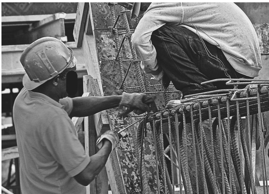
Figura 6.12. Há um enorme campo de ação nas necessidades de formação dos operários, mesmo em questões básicas como a forma correta de usar um equipamento de proteção individual. (Foto do Autor)
