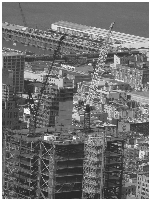
Figura 2.8. Nos estaleiros de obras construídas de raiz torna-se necessário empregar equipamentos para elevar cargas significativas, por vezes a grandes alturas como neste edifício em Nova Iorque. (Foto do Autor)
