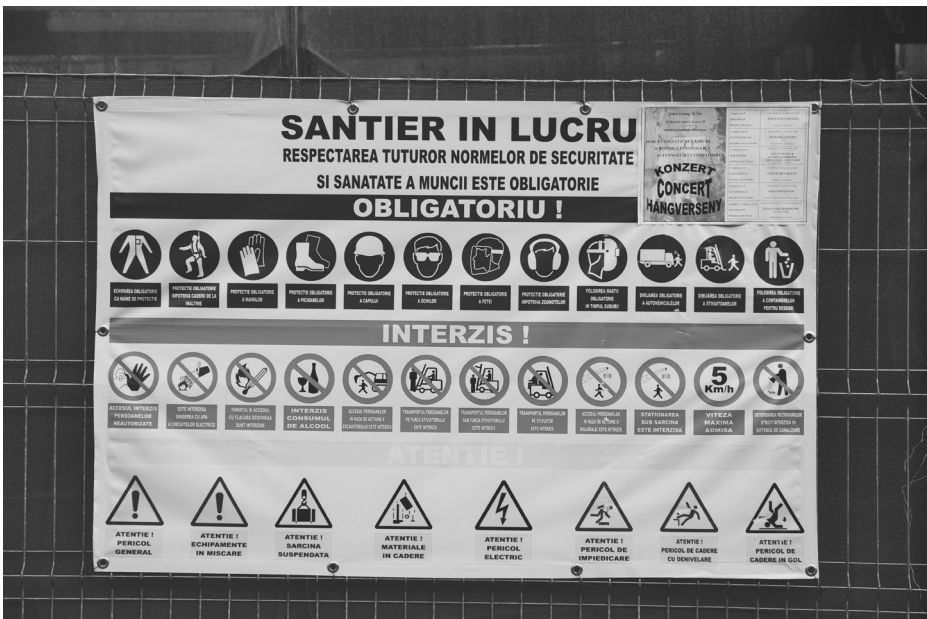
Figura 4.9. Sinalização afixada na entrada de uma obra em Sighisoara, na Roménia, mostrando medidas obrigatórias, interdições e aspetos a ter em atenção no estaleiro. As diretivas comunitárias permitem a utilização de regras comuns no mercado europeu. (Foto do Autor)
