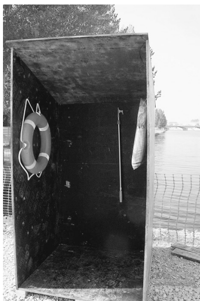
Figura 6.4. Equipamento de socorro contra o risco de afogamento na ensecadeira de uma obra de construção de uma ponte. (Foto do Autor)
