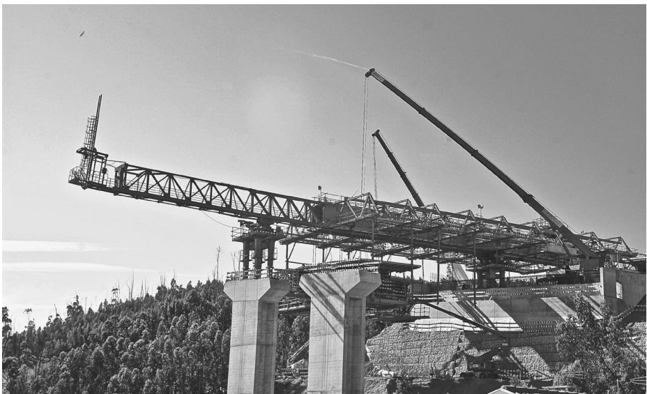
Figura 2.3. A utilização de equipamento pesado envolve operações com diversos perigos. Regras de operação estritas, equipa experiente, trabalho em altura, são requisitos que requerem atenção redobrada. (Foto do Autor)
