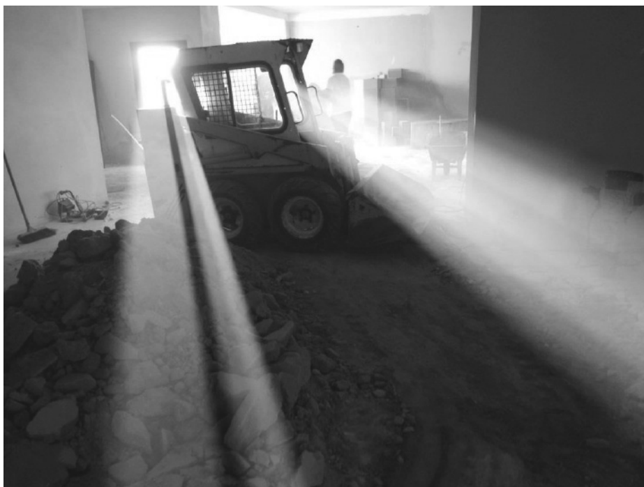
Figura 2.11. O trabalho em ambientes fortemente carregados de partículas gera doenças profissionais que se traduzem essencialmente em insuficiências respiratórias. O problema não é detetado imediatamente agravando-se, muitas vezes de uma forma sub-reptícia, num longo período de sucessivas exposições. (Foto do Autor)
