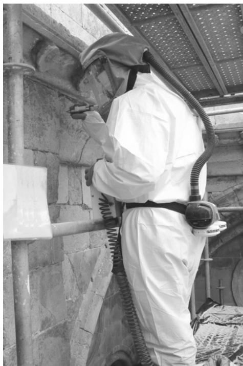
Figura 7.8. Um trabalhador utilizando um equipamento de proteção individual adequado à atividade desempenhada. Trata-se de um fato e máscara completa, com tomada de ar nas costas, na realização de uma operação de micro abrasão com partículas de óxido de alumínio. (Foto do Autor)
