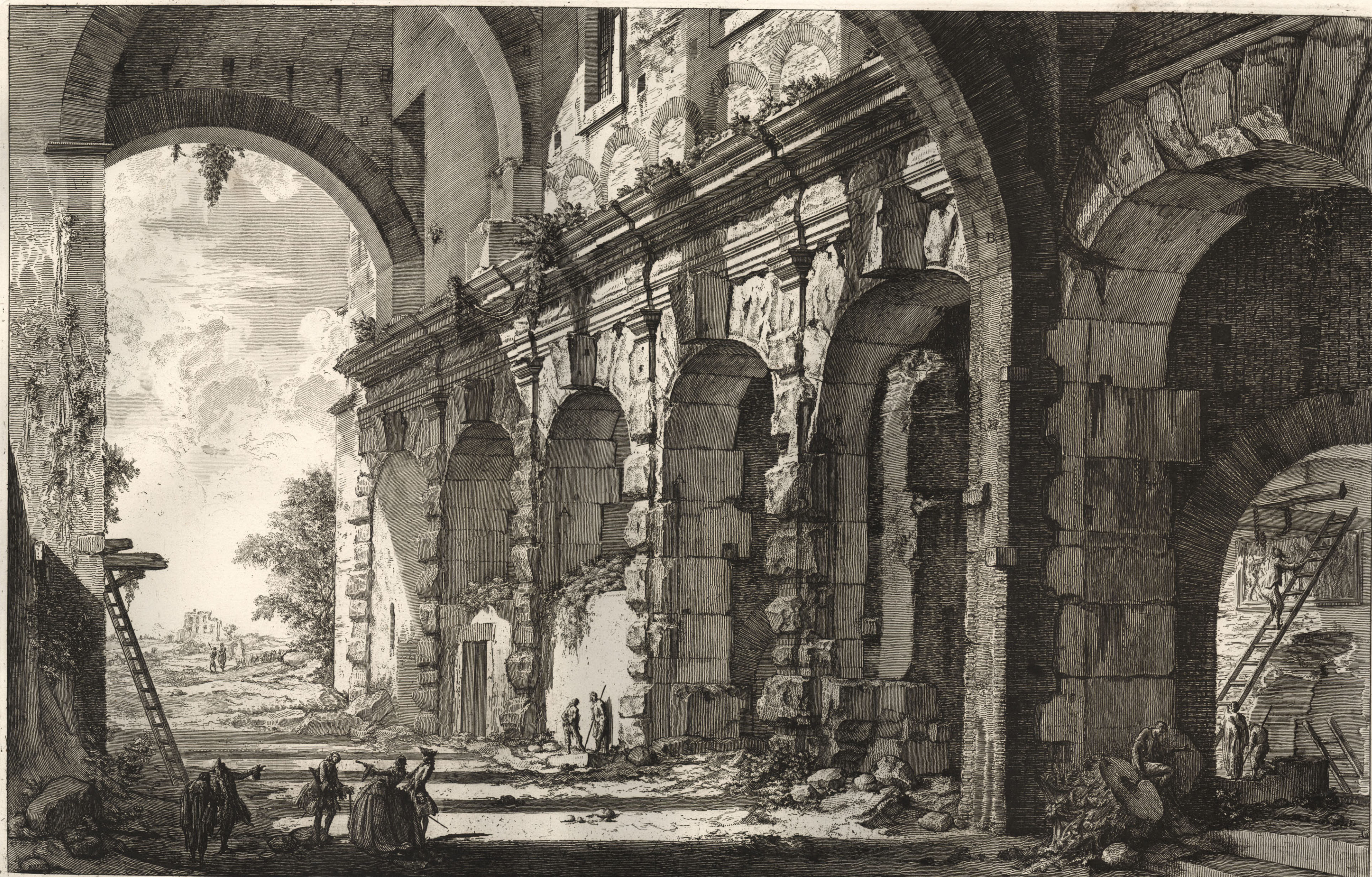
VEDUTA DEL PIANO SUPERIORE DEL SERRAGLIO DELLE FIERE FABBRICATO DA DOMIZIANO A USO DELL' ANFITEATRO FLAVIO, E VOLGARMENTE DETTO LA CURIA OSTILIA Tiranesi Architetto fecit. Il primo piano di questa gran fabbrica rimane interrato nelle rovine, che inoggi uguagliano il piano di Roma, e dagli scavi fatti, si è trovato parimente composto di grossi macigni di travertino. A. Segni, ove si appoggiavano i muri di tavolozza che serravano gli archi. B. Muri de' tempi bassi. Sopra di questi Archi è fabbricato il Campanile e Convento de' Padri della Alleanza di SS. Giovanni, e Paolo. Presso l'autore a Strada Felice vicino alla Trinità de' monti.
