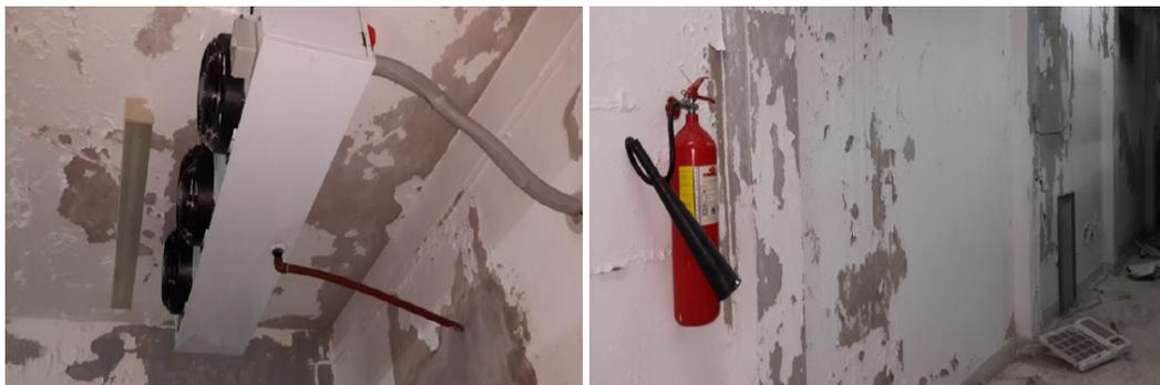
O tecto e as paredes do arquivo de filmes também sofreram com a infiltração das águas pluviais durante quase duas décadas, o que obriga a instituição a constantes trabalhos de reabilitação.
