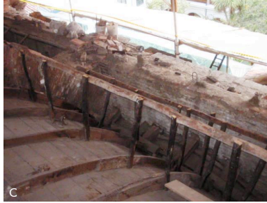
Fig. 4. (a) Elementos que forman la bóveda de madera; (b) y (c) Imágenes de la bóveda en madera
