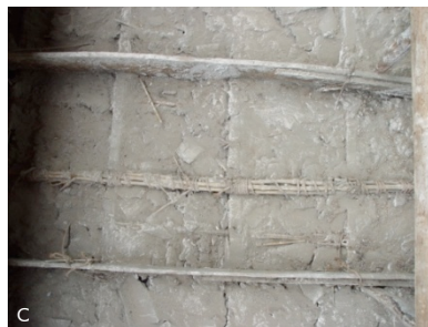
Fig. 5. (a) Elementos que conforman la bóveda de bahareque; (b) y (c) Imágenes de la bóveda de bahareque
