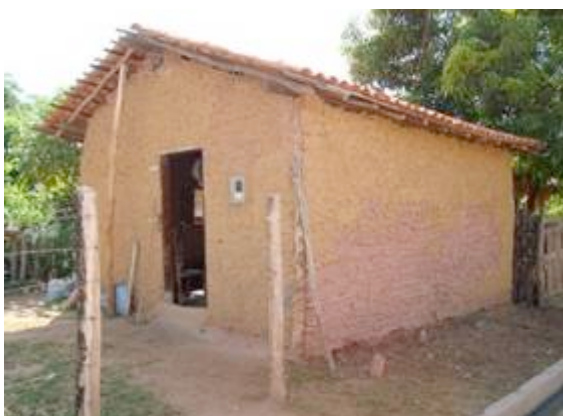
Fig. 3 e 4 - Construções de taipa de mão na Vila Cidade Leste, na Zona Leste e no bairro Aeroporto, Zona Norte de Teresina. (Crédito: Thaís Carvalho, 2009).
