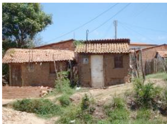
Fig. 3 e 4 - Construções de taipa de mão na Vila Cidade Leste, na Zona Leste e no bairro Aeroporto, Zona Norte de Teresina. (Crédito: Thaís Carvalho, 2009).
