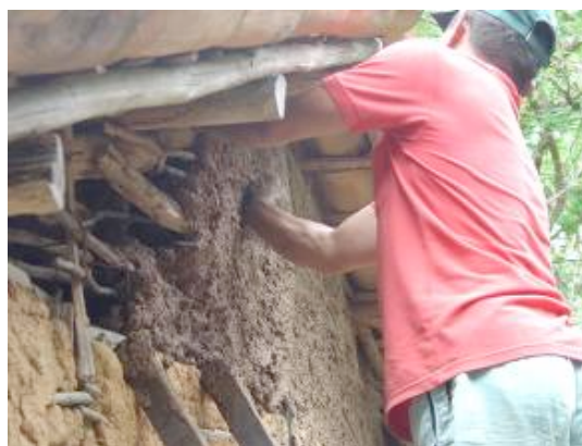
Fig. 4. A tapação da casa de taipa (créditos: acervo do Grupo de Pesquisa Estudos da Paisagem, 2008)
