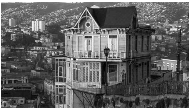
Fig. 3. Casa del cerro Artillería de Valparaíso, de Barison y Schiavon, 1908.
