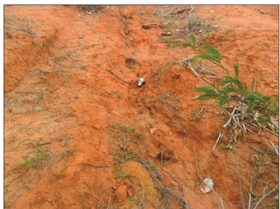
Fot. 6 - Aspectos da encosta com solo compactado e exposto a erosão hídrica (Maria Ramalho, em Teixeira (Sítio Poços), 2014).
