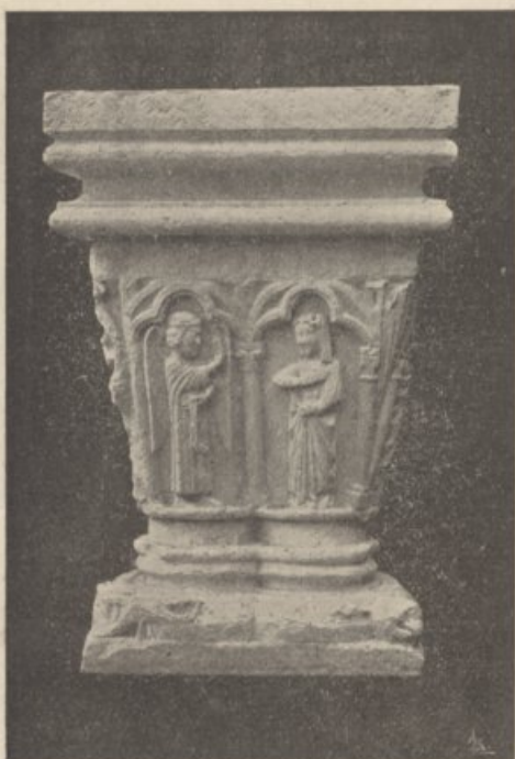
Capitel com dois arcos trilobados e respectiva base, do edificio dionisiano da Universidade em Coimbra
