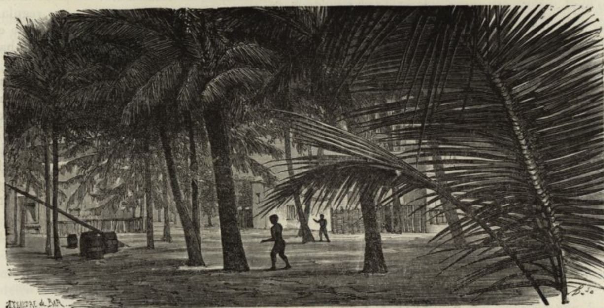
INTERIOR DO CAMPO ENTRINCHEIRADO NO GRÃ-BASSAM — Desenho de A. de Bar, segundo uma photographia
