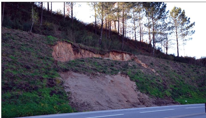
**Fot. 3** - Deslizamento rotacional em talude de estrada, no município de Póvoa de Lanhoso (Fotografia de António Vieira, 2017).
