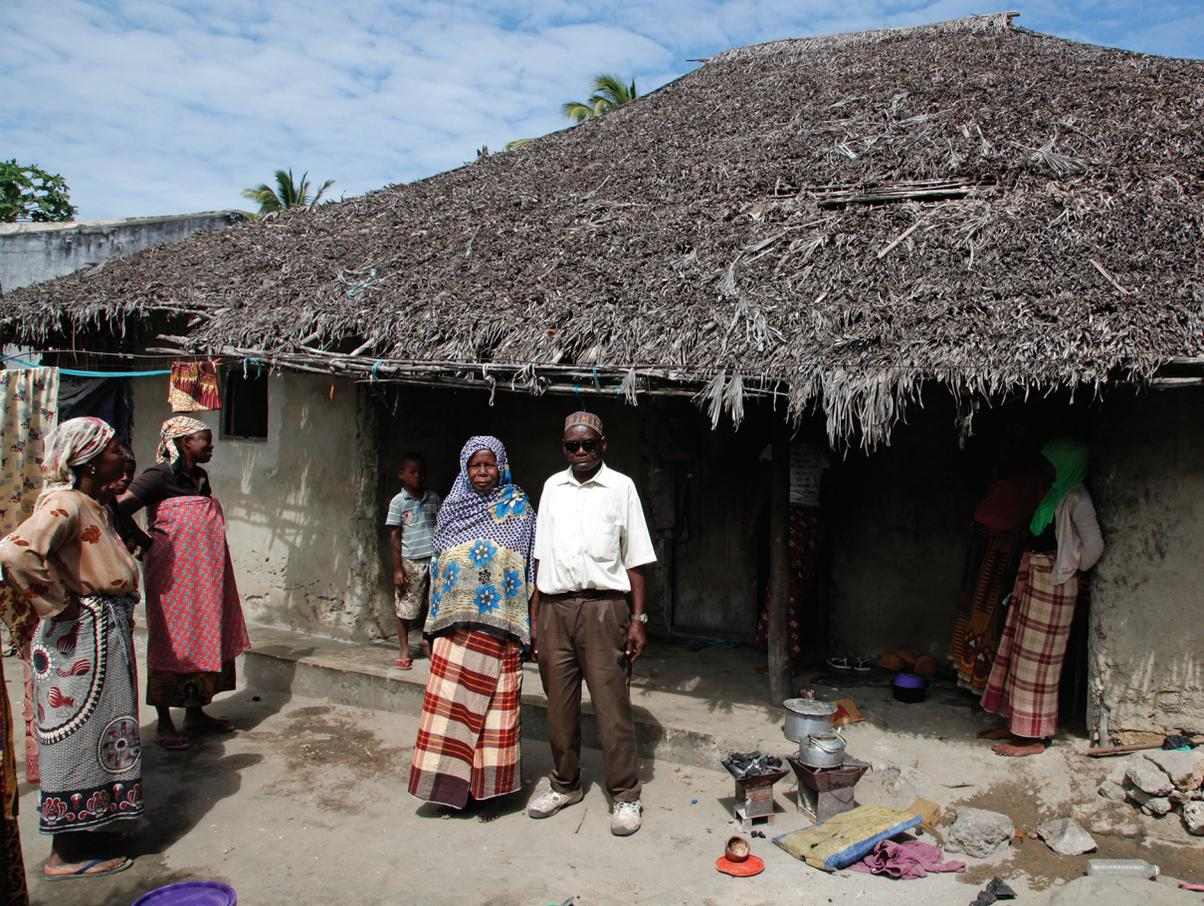
Uma das casas em requalificação, integralmente construída em cana e com paredes exteriores e interiores engradadas para acolher pedra de coral, estrutura-se em prumos e tirantes de madeira, sobre os quais e em posição central se implantam os prumos (*tucas*) de apoio do rincão superior (*mamba*), onde amarram superiormente as varas das pendentes. Estas, em sentido inverso, pousam no frechal periférico. Sob este, fixam-se os aros das janelas/portadas e das portas.
