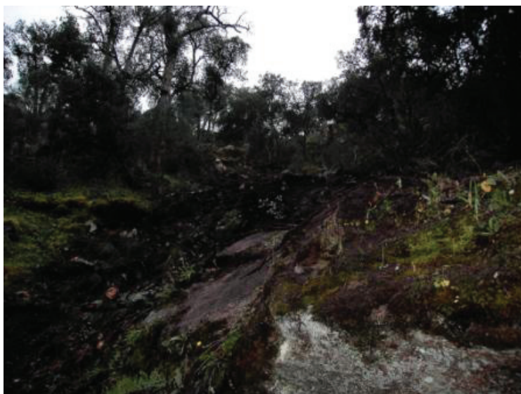
Fot. 2 - Aspeto da vertente após o acidente (Autora: Maria Gouveia, 2007). Photo 2 - Slope's appearance after the accident (Author: Maria Gouveia, 2007).
