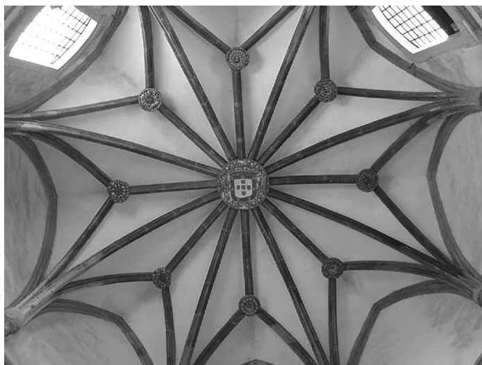
Fig. 2 – Abóbada da igreja de Santa Maria de Celas. Foto: IGESPAR
