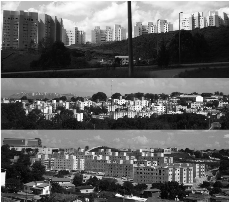
Fig. 2 - Cenas do ambiente construído, RMBH Fonte: fotos da autora, 2012.
