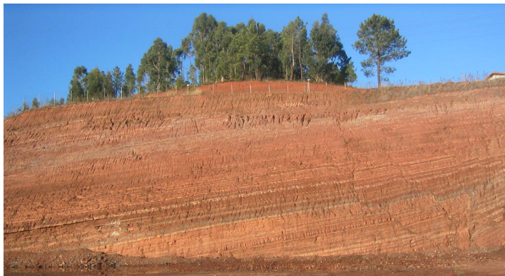
Figura 8. Vista do talude Este da Quinta da Portela que, apesar de ter cerca de 15m, não apresenta problemas de instabilização.
