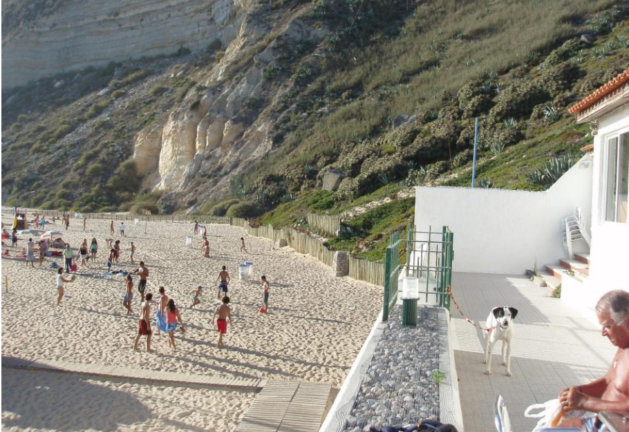
Fot. 11 - Praia da Nazaré (2006). Alinhamento de estacas delimitando a área considerada perigosa.
