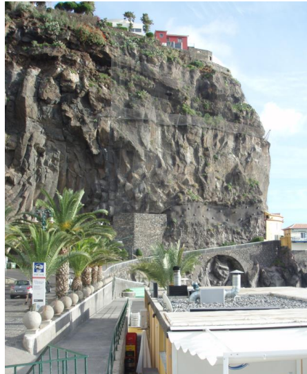
Fot. 15 - Ponta do Sol, Madeira (2009) - arriba basáltica, com elementos frágeis, totalmente trabalhada por obra de proteção complexa, tendo em vista prevenir crises provocadas por desabamentos.
