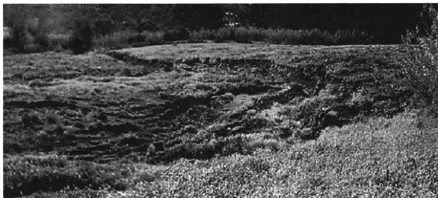
Fig. 2 – Aspecto do escorregamento em análise.
