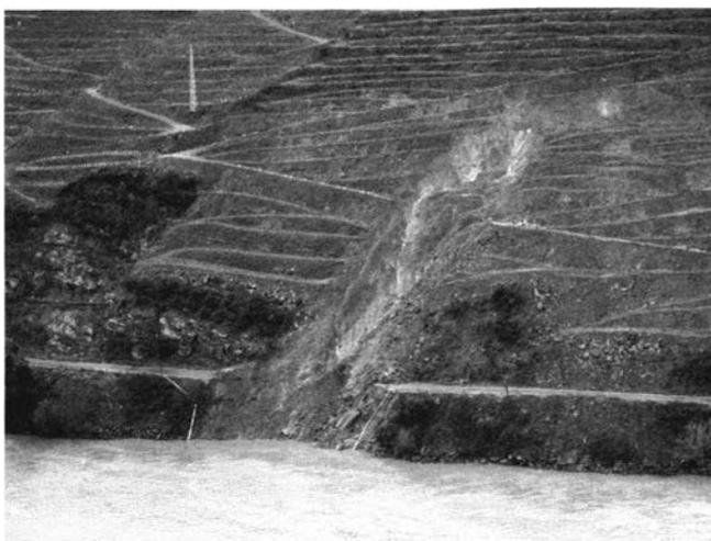
Fig. 4 – Deslizamento na estrada Régua-Pinhão (Janeiro de 2003).
