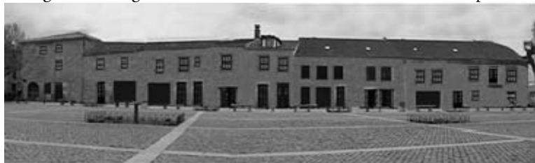
Figura 2 – Largo da Avenida – Revestimento das fachadas em pedra
