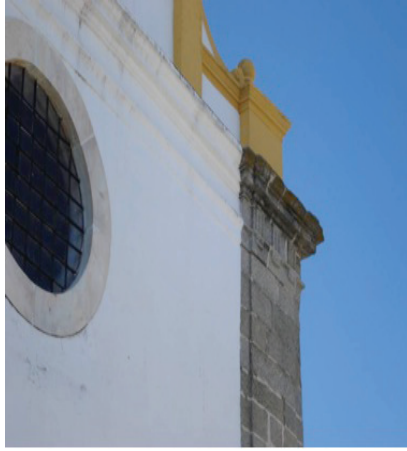
Fig.7. Igreja do Convento do Senhor Salvador do Mundo. Évora (1610). Fachada axial. Detalhe de óculo, friso contínuo liso e cornija de múltiplo ressalto e cunhal com elementos decorativos de tipologia dórica
