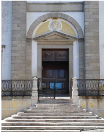
Fig.1. Manuel Pires, Afonso Álvares e Brás Godinho. Igreja de Santo Antão. Évora (1577). Fachada axial. Acesso e portal central emoldurado entre arco redondo e pilares-contraforte centrais
