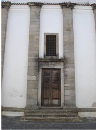
Fig.5. Igreja do Convento de Santa Helena do Monte Calvário. Évora (1578). Fachada lateral. Detalhe do portal central, com duplo adintelado, e articulação com abertura superior entre pilares-contraforte
