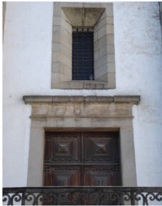
Fig.4. Igreja de Santo Antão. Évora (1577). Fachada. Detalhe do portal lateral nascente, com duplo adintelado, e abertura superior
