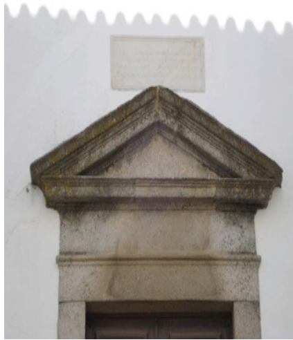
Fig.6. Igreja do Convento do Senhor Salvador do Mundo. Évora (1610). Fachada lateral poente. Detalhe do portal central, com duplo adintelado e frontão triangular com cornija e múltiplo ressalto
